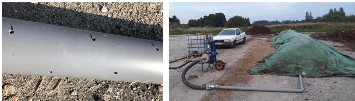
Joonis 50. Vasakul auna põhja asetatud toru ja paremal biofilter koos katte all oleva kompostiaunaga.
