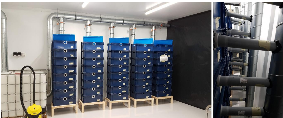
Joonis 9. Uus kasvatuskastide süsteem. Vasakpoolsel pildil on näha kastide ventilatsiooniavad, mis süsteemi tööerakendamisel on suunatud tahapoole ventilatsioonitorustiku poole. Paremapoolsel pildil on näidatud ventilatsioonitorud kasvatuskastide tagaküljel.
