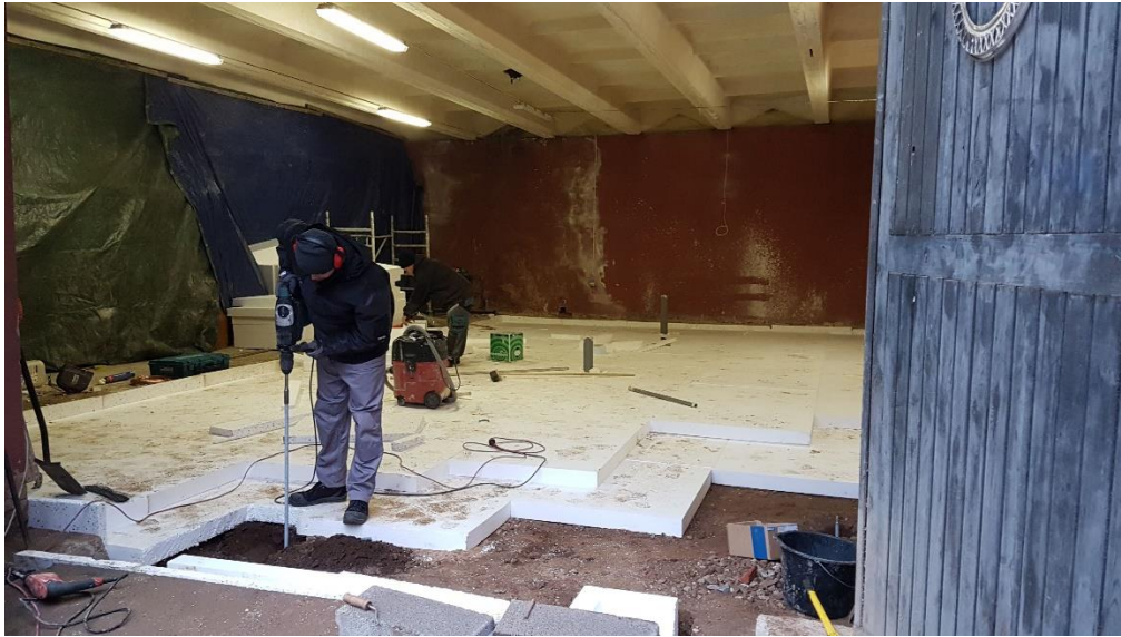
Joonis 4. Põranda soojustamine.
