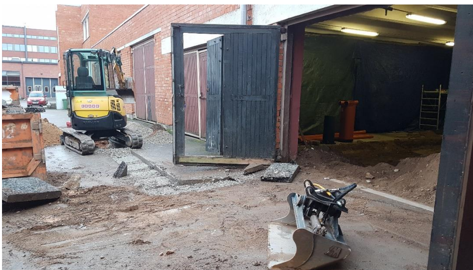
Joonis 3. Lammutustööd ja kanalisatsioonitrassi ehitus.
