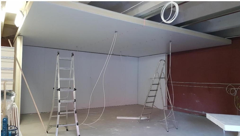
Joonis 5. Seinte ja lae paigaldamine.
