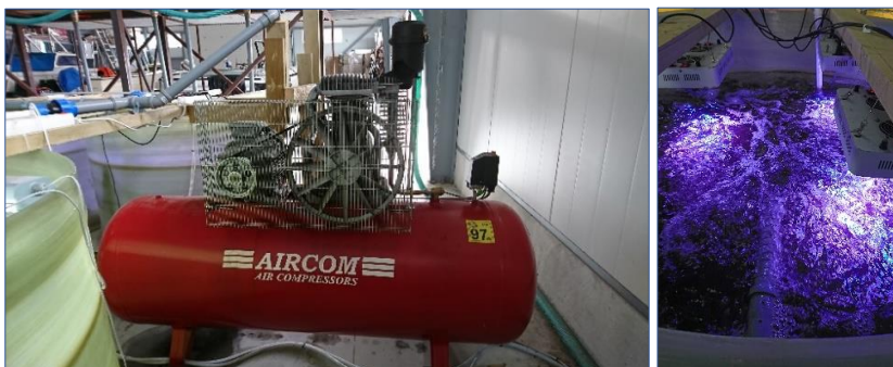
Joonis 2.2.8. Mahutite õhutamine (paremal) õhukompressoriga AIR660 (vasakul).
